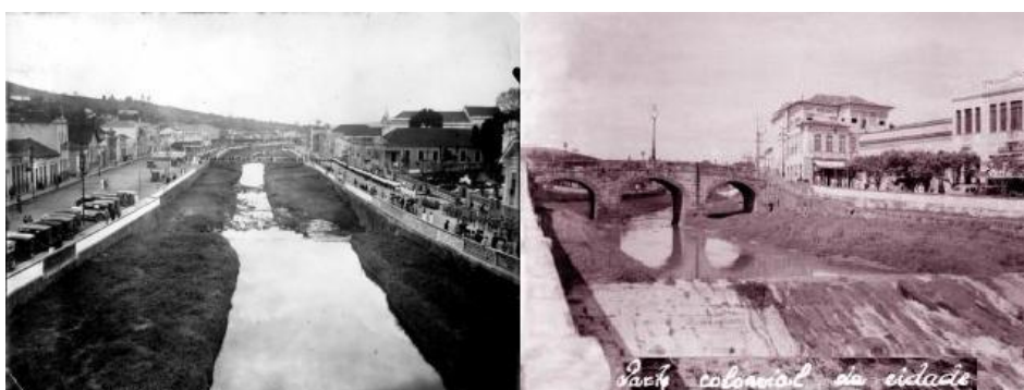
Figura 1: Córrego do Lenheiro antes da Canalização
